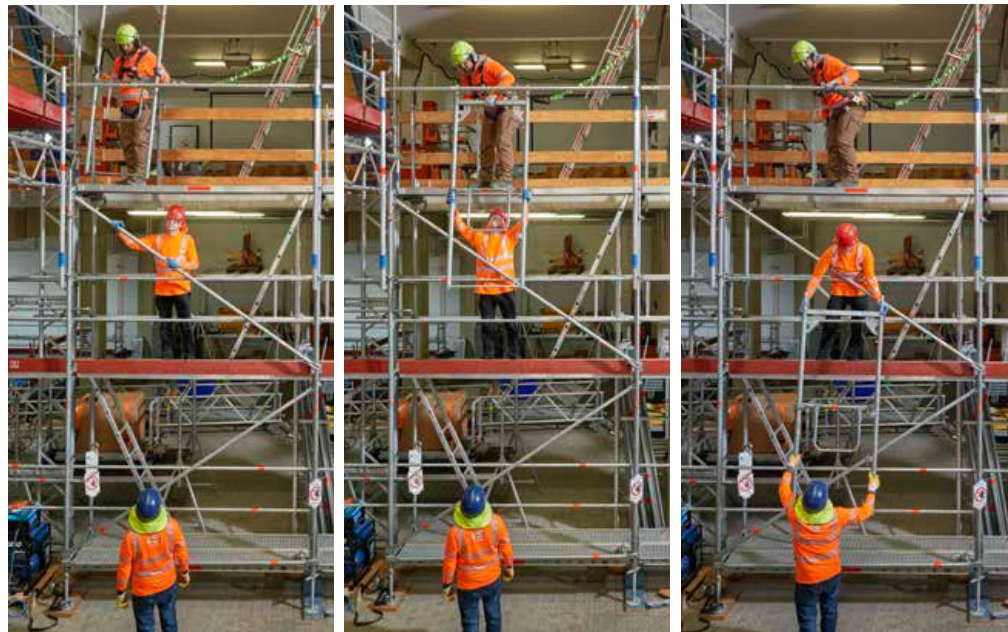
Bei durchgehender Gerüstflucht auf der obersten Gerüstlage muss mindestens ein einteiliger Seitenschutz oder ein Montagesicherungsgeländer installiert sein, bevor von dort aus weiter montiert, um- oder abgebaut werden darf.
